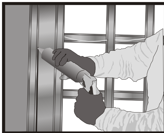
2.- Selle cualquier ruptura o agujero alrededor de piso, techo o pared, solera superior e inferior y detrás de cajas de empalme por donde pueda haber penetración de aire con sellante adhesivo.
