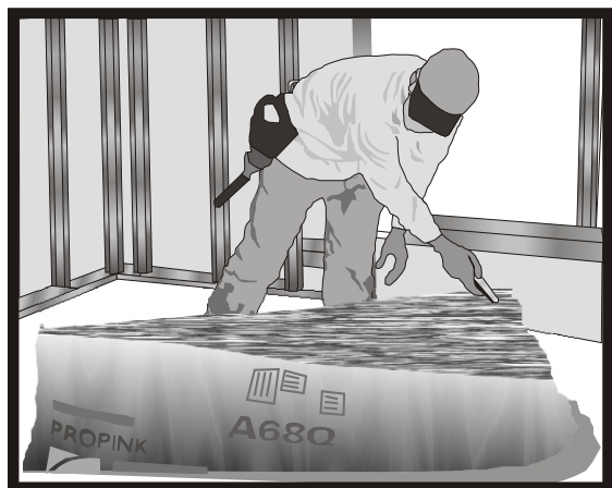
3.- Antes de abrir los paquetes colóquelos en el cuarto donde serán instalados. La manera de abrir el paquete es: cortando a lo largo con una navaja. El aislamiento viene comprimido, por lo que al abrirlo se expande, cuide que tenga suficiente espacio.
